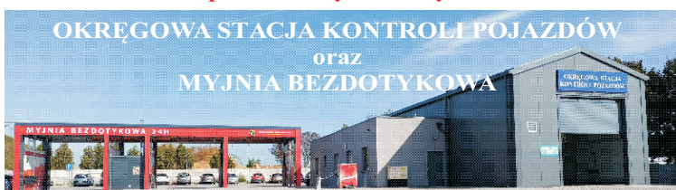
Pleszew, ul. Kaliska 153a (przy Wodociągach)
